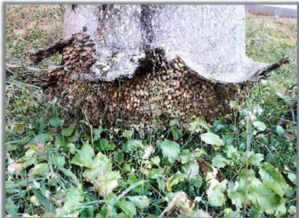
Fig. 2: Palmeira em frente ao bloco B2, cujas raízes estão expostas
